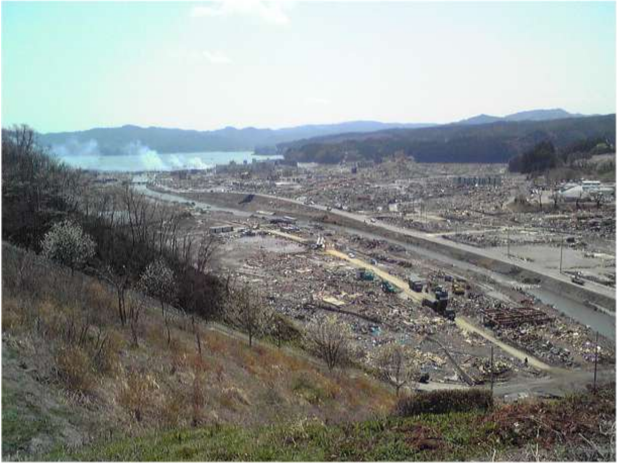
図1 被災した南三陸町志津川地区（志津川小学校から写す。2011年4月）
